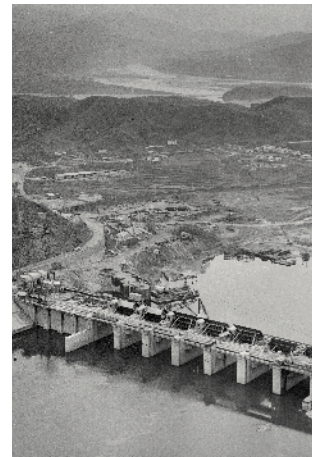
팔당댐 건설 항공사진 / 1972
